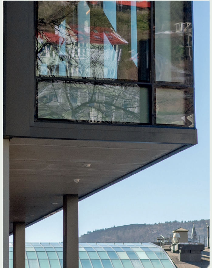
De påbygde etasjene krager ut over resten av bygget.
